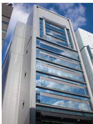
大阪本社：辰野南本町ビル
